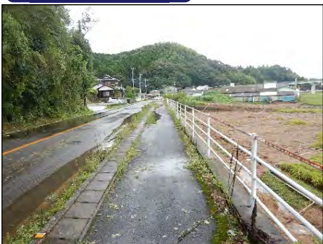
行藤川堤内痕跡状況(9月19日09:40頃)
