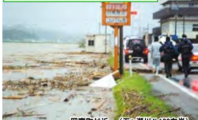
岡富町付近 (五ヶ瀬川4k100左岸)
