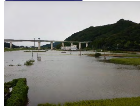
五ヶ瀬川右岸9k600付近堤内(9月19日09:00頃)
