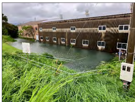
祝子川右岸1k200付近堤内(9月19日08:00頃)
