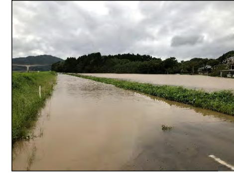
五ヶ瀬川左岸8k600付近堤内(9月19日07:00頃)
