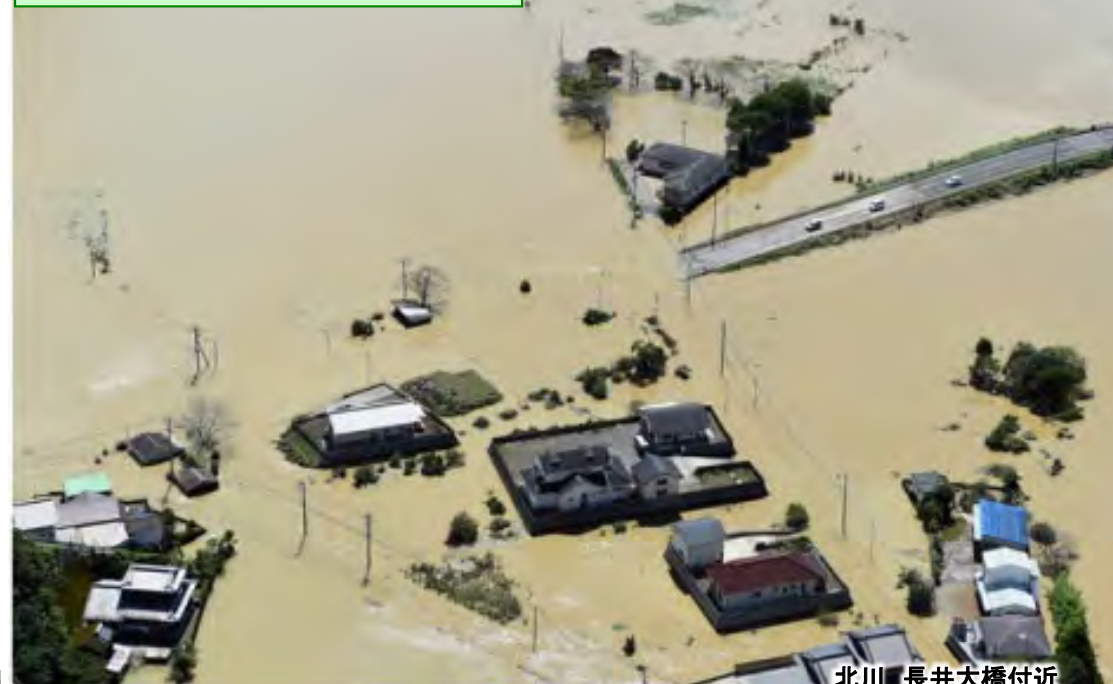
平成28年(2016年)9月洪水 床上浸水 22戸、床下浸水 77戸
