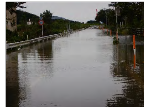
五ヶ瀬川右岸9k200付近堤内(9月19日09:10頃)
