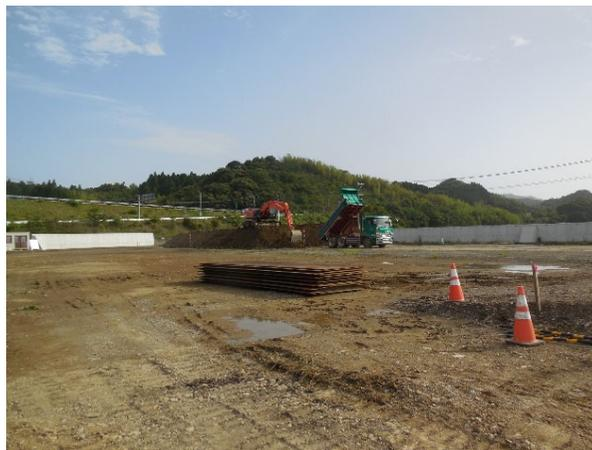
掘削残土を用いた五ヶ瀬川河川防災ステーション敷地の基礎整備(天下地区)(R3.5)
