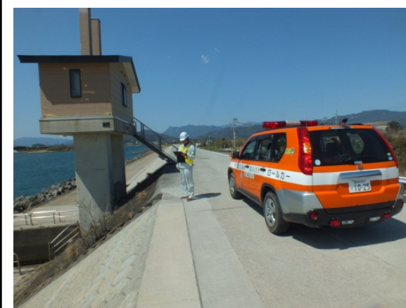
日常の管理(河川巡視)
