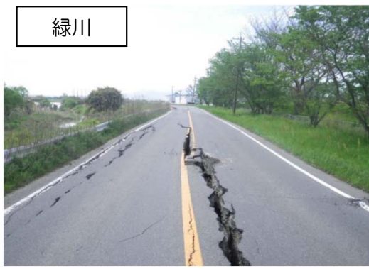
地震による堤体の変状
