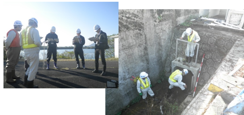
点検業者と職員による樋門等の点検を実施
