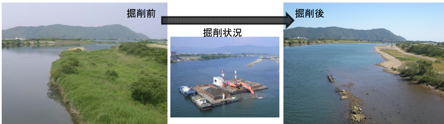
大瀬川下流部(方財地区)の河道掘削を実施
