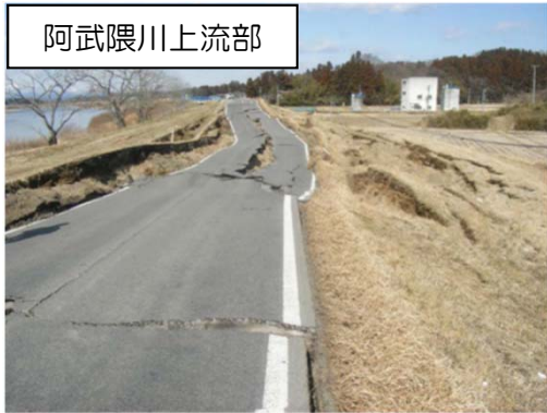
地震による堤体の変状
