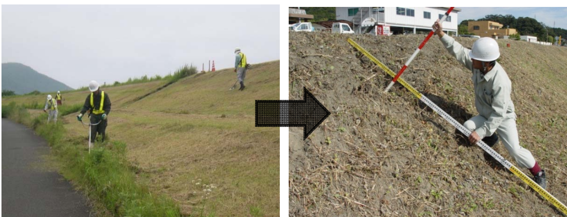
堤防除草を行い、堤防点検を実施
