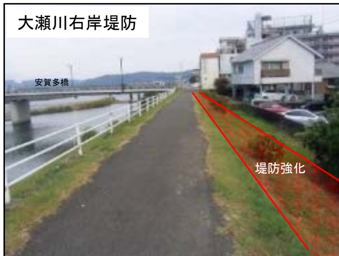
堤防裏法尻をブロック等で補強
