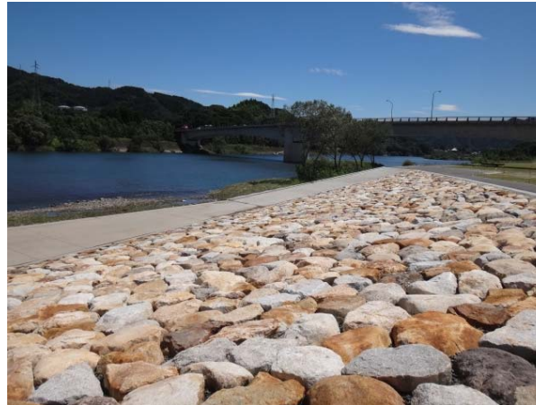
巨石を使用した石張工(大貫地区)
