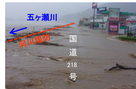
おかとみ 浸水状況(岡富地区)
