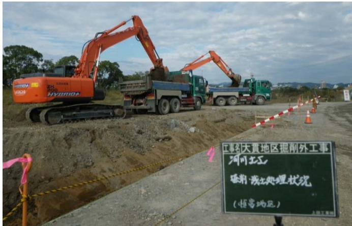
掘削残土処理状況(恒富地区)
