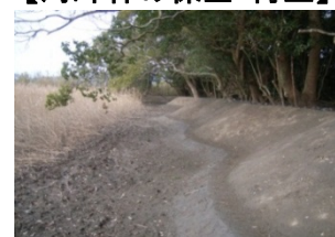
露出した河畔林の根を覆土し、河畔林を保全
