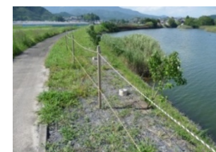
整備後 河岸に盛土してハマボウを主に植樹
