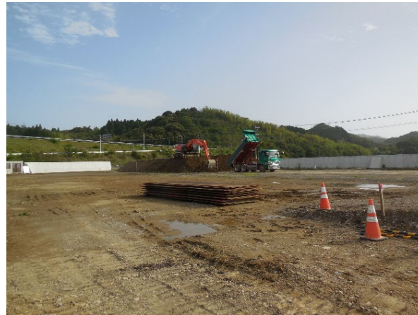
掘削残土を用いた五ヶ瀬川河川防災ステーション敷地の基礎整備(天下地区)(R3.5)
