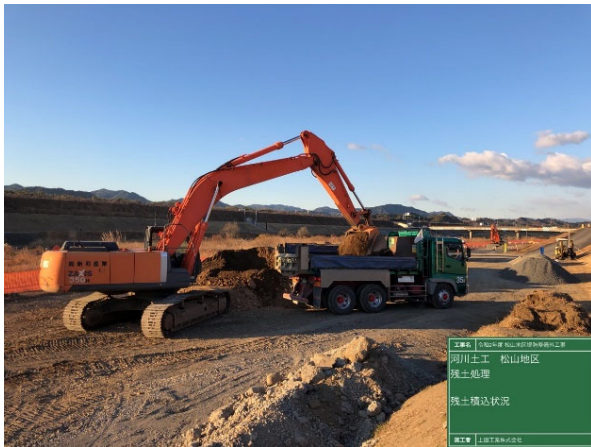
掘削残土処理状況(松山地区)(R3.1)
