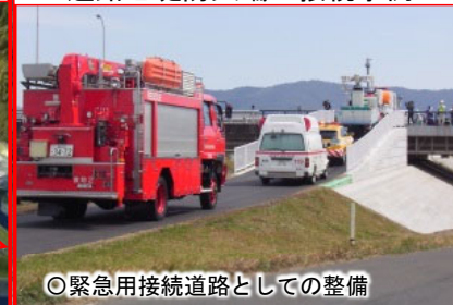
道路と堤防天端の接続事例
