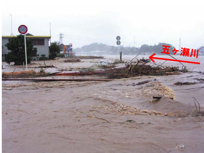
岡富町 五ヶ瀬川左岸 5k100
