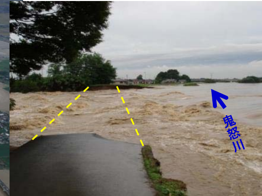
被災状況(拡大写真)
