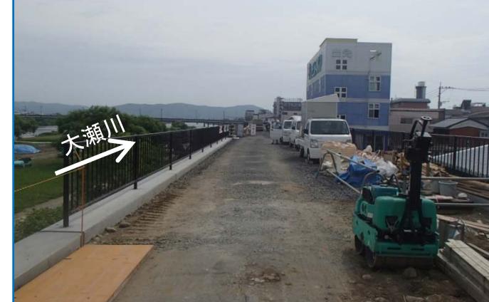
堤防拡張工事を終え、アスファルト舗装工事を実施中。
