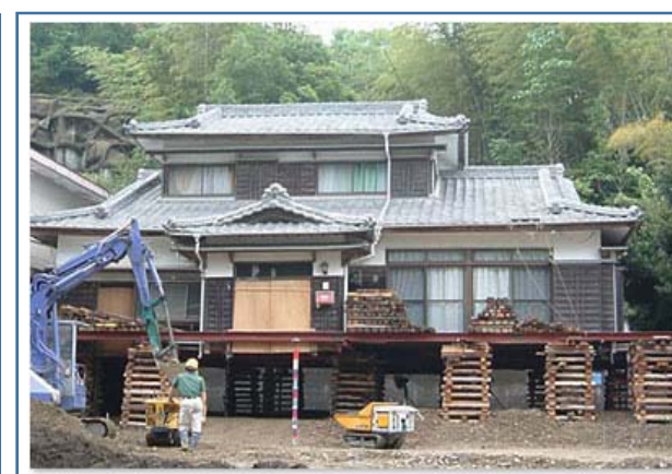
※宅地嵩上げの施工事例
