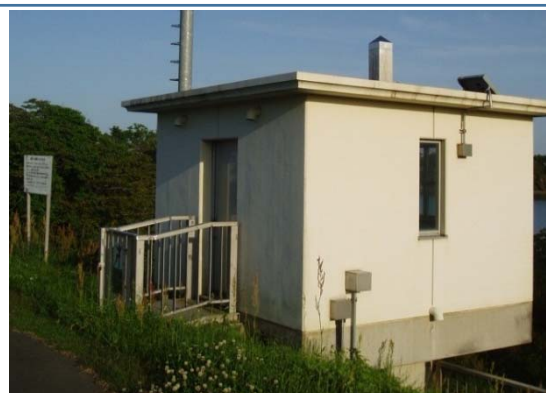
大武排水樋管
