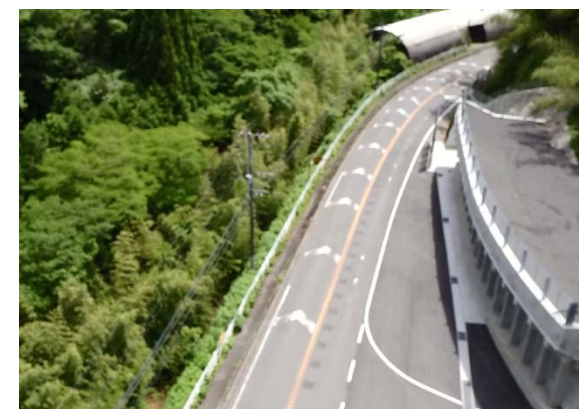
訓練時の国道218号 ドローン画像
