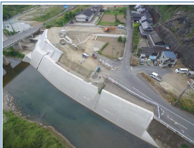
五ヶ瀬川 細見地区
