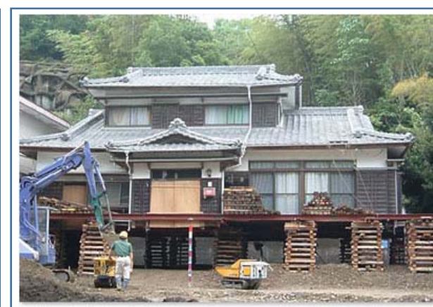
※宅地嵩上げの施工事例
