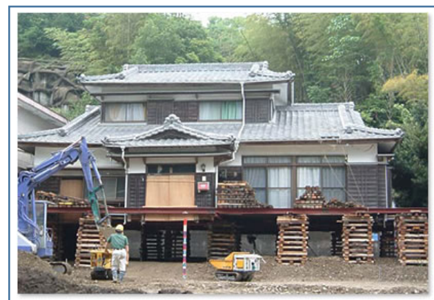
※宅地嵩上げの施工事例
