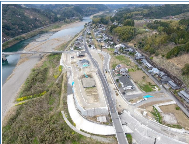
五ヶ瀬川 細見地区
