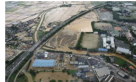
④桂川における浸水被害 (福岡県朝倉市)
