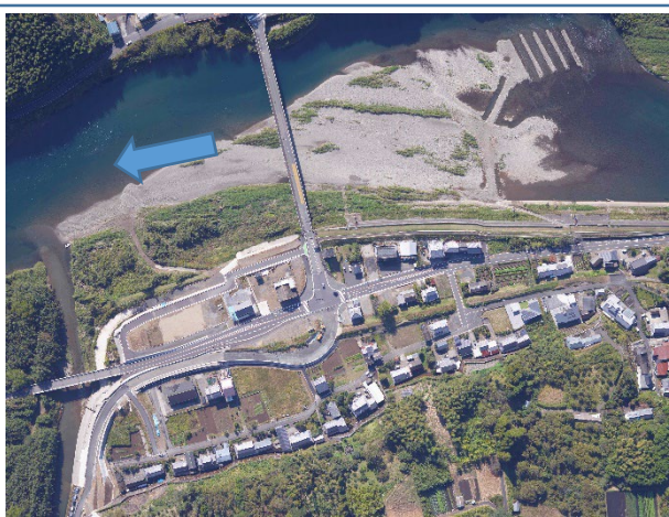
五ヶ瀬川 細見地区(輪中堤)
