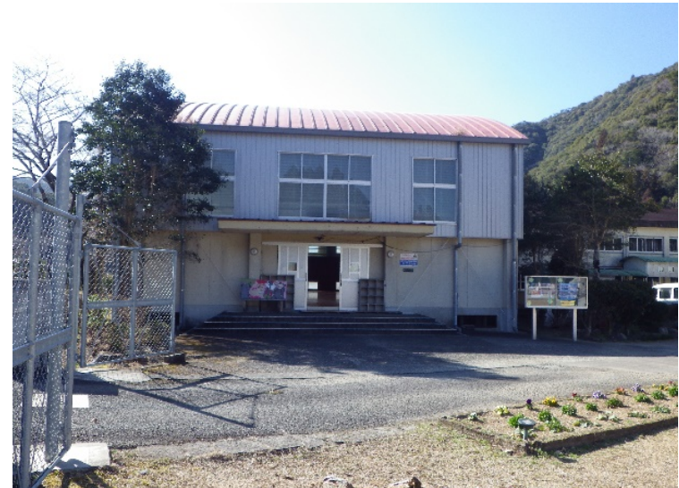
多目的トイレ設置予定の避難場所 （三川内小中学校体育館）
