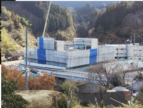
R3年1月時点 建設状況
