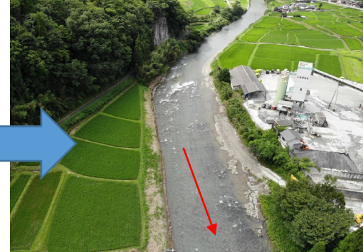
五ヶ瀬川(鞍岡地区)【実施後】
