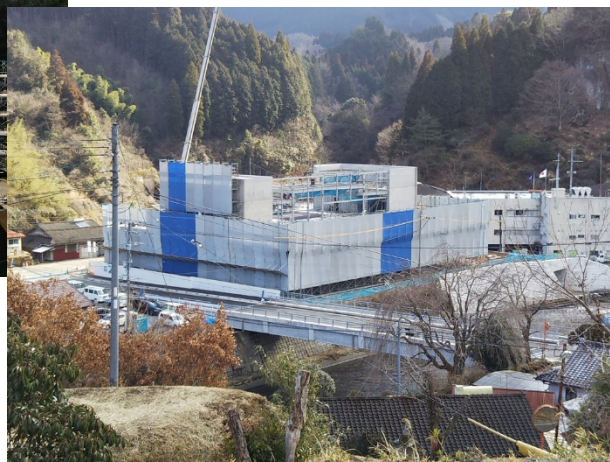
R3年1月時点 建設状況
