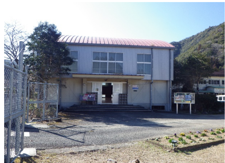
多目的トイレ設置予定の避難場所 （三川内小中学校体育館）
