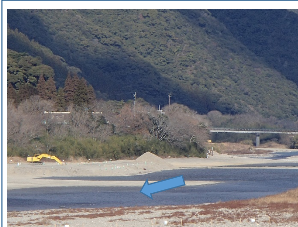
北川 笹首地区(河道掘削)
