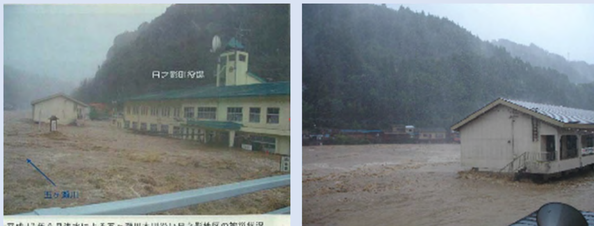
平成17年9月洪水による五ヶ瀬川本川沿い日之影地区の被災状況
