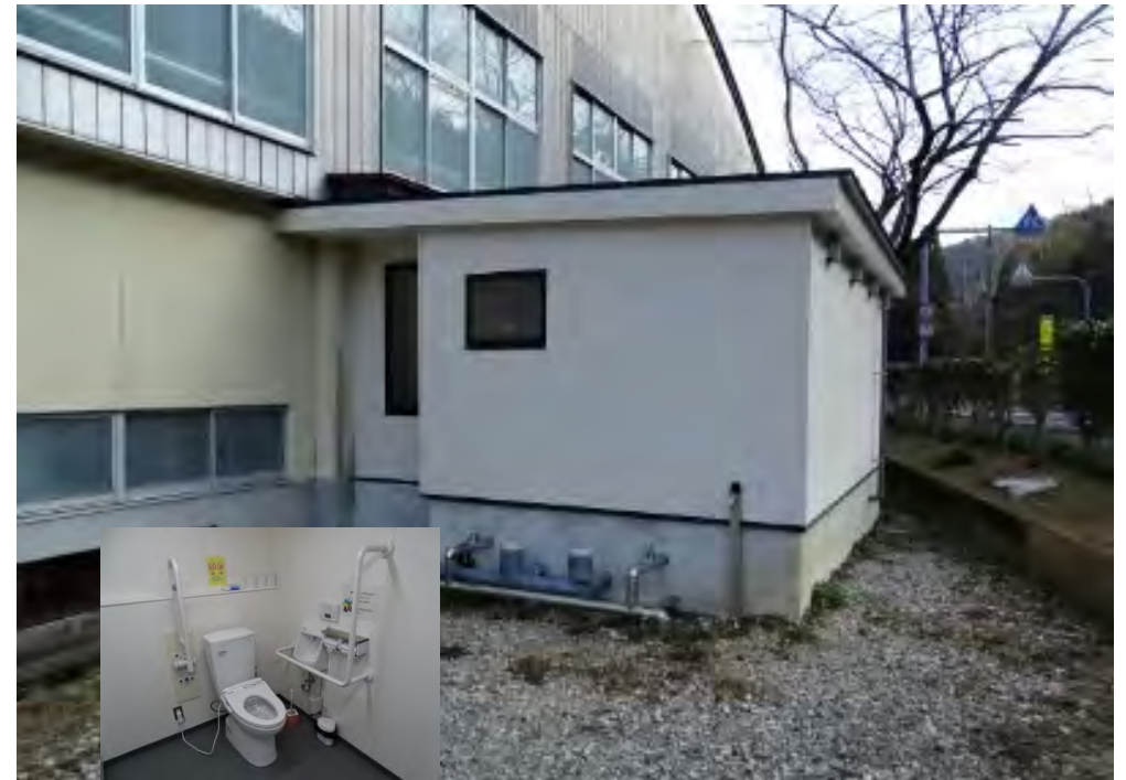
多目的トイレ設置後の三川内小中学校体育館
