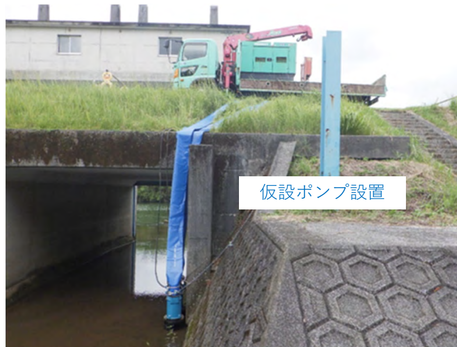
富美山地区の応急処理状況
