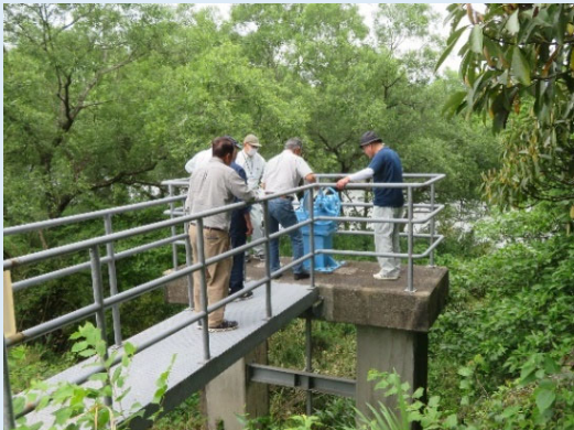
延岡市土地改良区(樋門)
