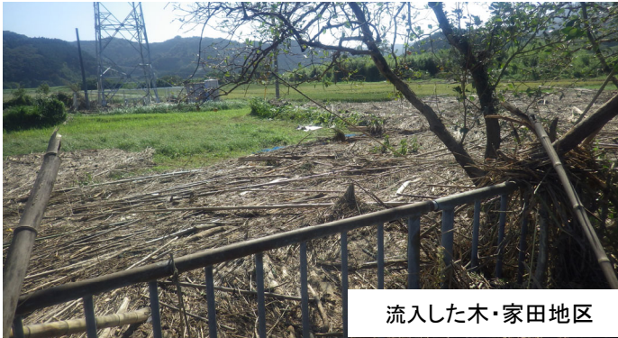
R4年9月台風14号 流入物被害
