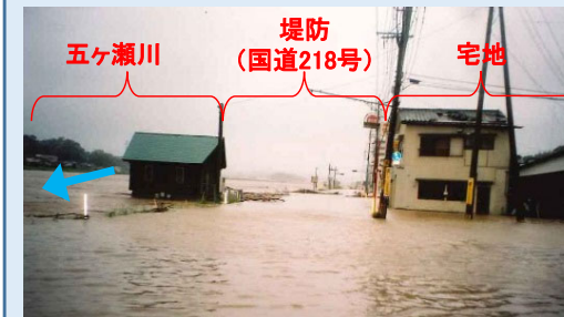
平成17年9月 台風14号 被災状況
