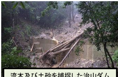
流木及び土砂を捕捉した治山ダム
