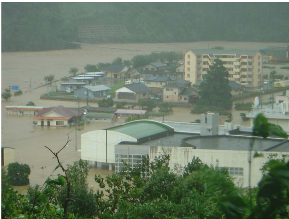
延岡市北方町川水流 宮崎県管轄
