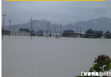
浸水の状況(新潟県燕市西野地区)
