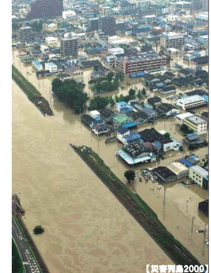
約100mにわたって決壊した新川左岸堤防 (愛知県名古屋市)
