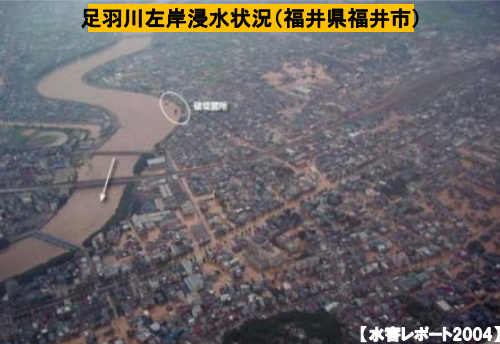
足羽川左岸浸水状況(福井県福井市)
