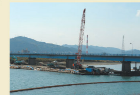
河道掘削(鶴島橋付近)
