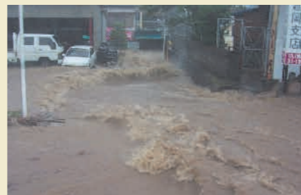
洪水による堤防からの越水状況(岡富地区H17.9台風14号出水時)
