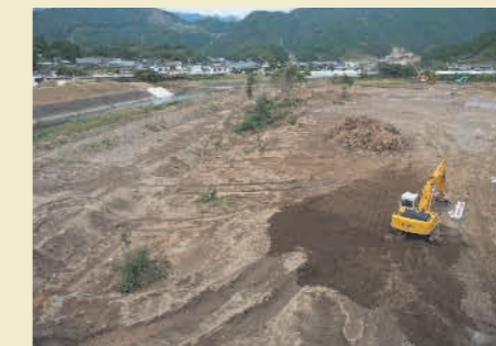
五ヶ瀬川の松山橋上流右岸(野田地区)の河道掘削状況
