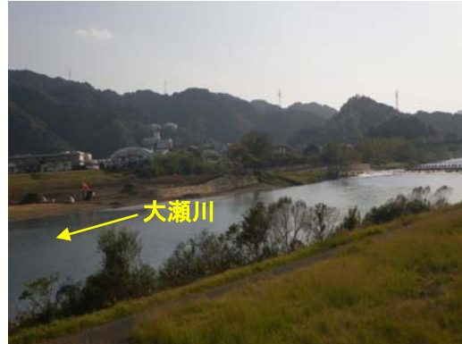
写真 2-2-4 大瀬大橋下流
