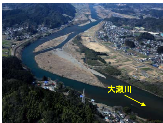
写真 2-2-1 大瀬大橋上流
