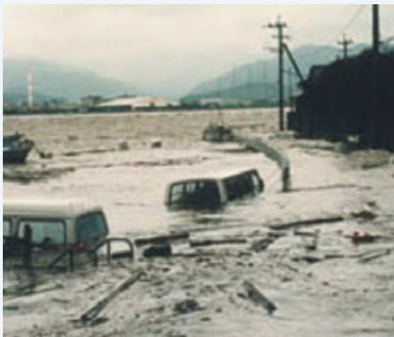
平成 9 年 9 月台風 19 号 北川（延岡市 東海地区）
