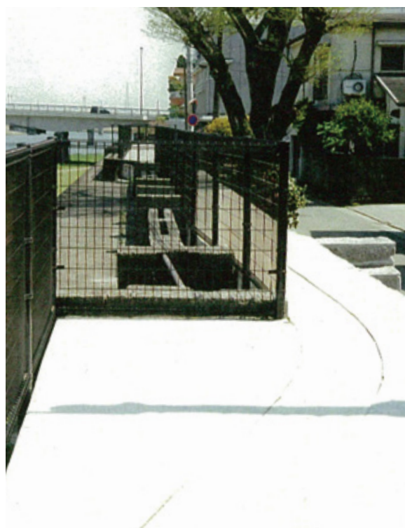
改修工事完成後
