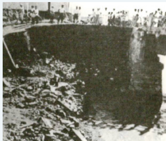
昭和 29 年 大瀬橋付近
