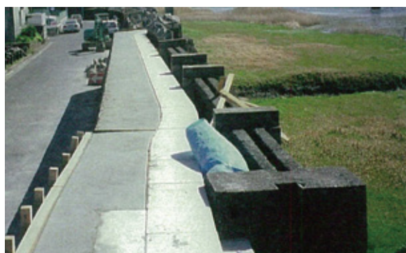
改修工事施工中の様子
