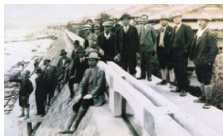
(写真-1) 畳堤竣工式の写真③
