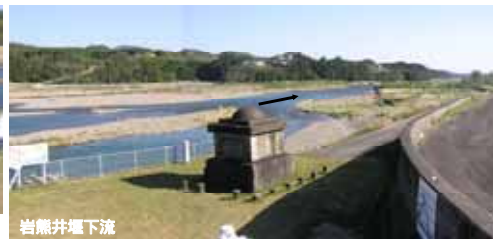
岩熊井堰下流
