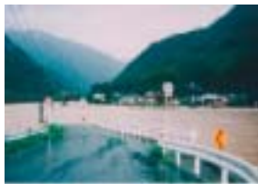
平成9年9月浸水状況(桑平地区)
