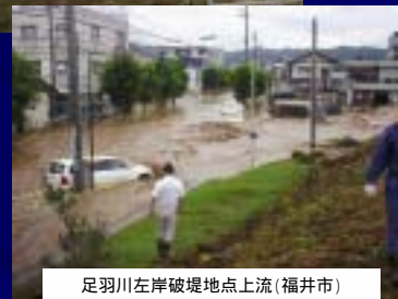
足羽川左岸破堤地点上流(福井市)
