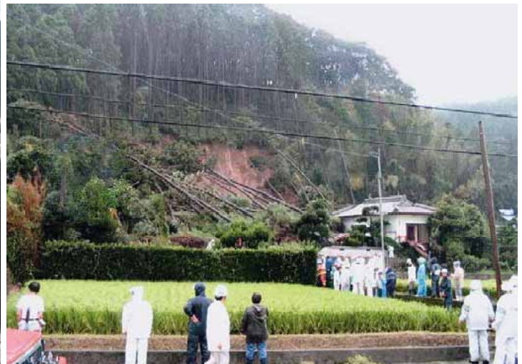
⑱三股町切寄地区地すべり
