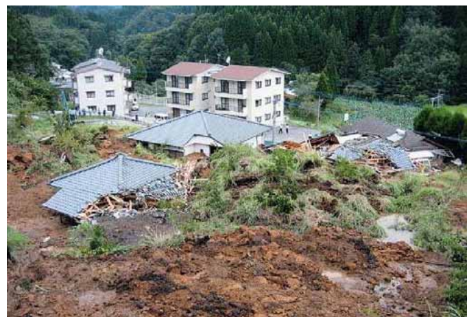
⑥五ヶ瀬町室野第3地区がけ崩れ
