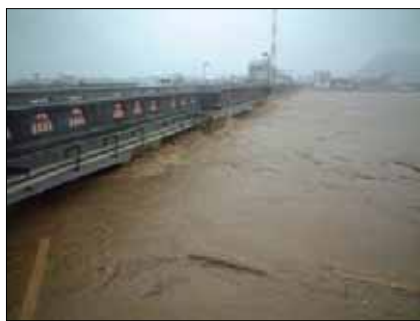
安賀多橋 (大瀬川3k400付近)
