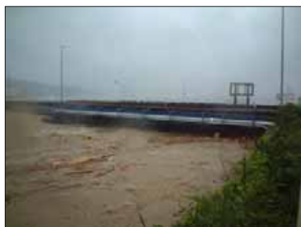
大瀬橋 (大瀬川3k800右岸)
