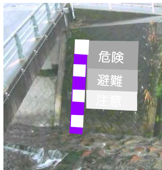
〔設置後(通常時)〕
