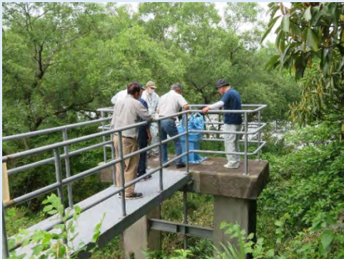
延岡市土地改良区(樋門)
