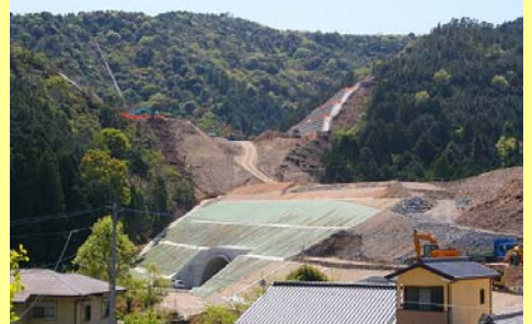
法面保護工事
