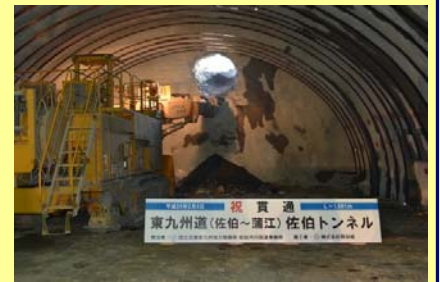
貫通した佐伯トンネル
