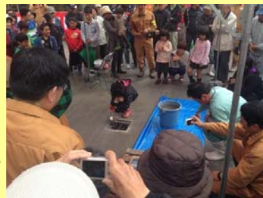
最後の打設風景
