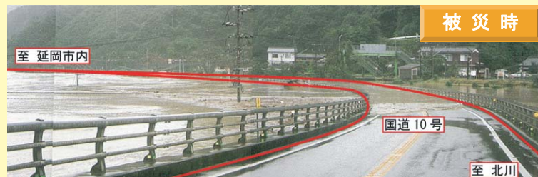
H9年 台風19号大水害路面冠水による全面通行止め
