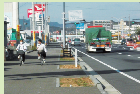
▲ 整備後の歩道の状況(財光寺地区)
