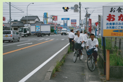
▲ 整備前の歩道の状況(財光寺地区)
