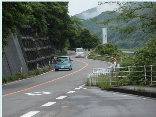
▲国道218号現道の状況
