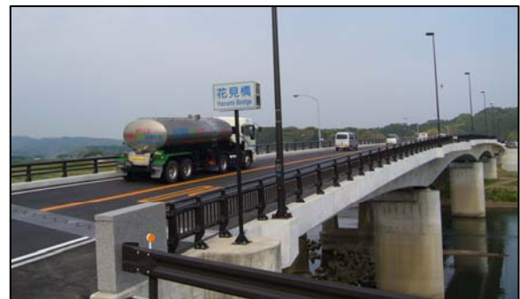
▲ 旧橋架替えによる部分供用
