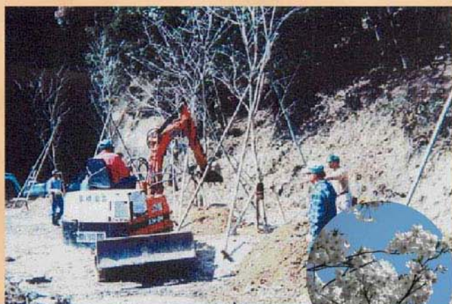
桜の植栽作業の様子
