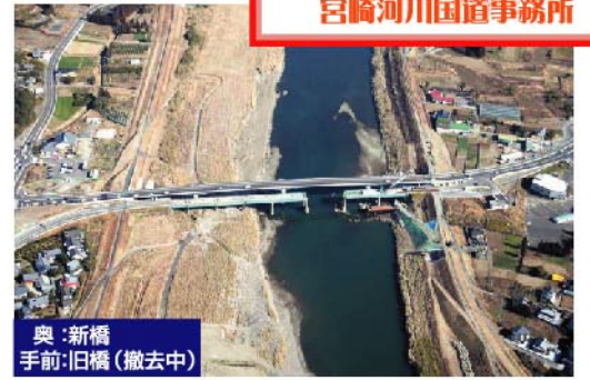
花見橋旧橋撤去
