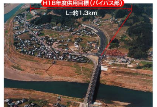
バイパス部改良工事
