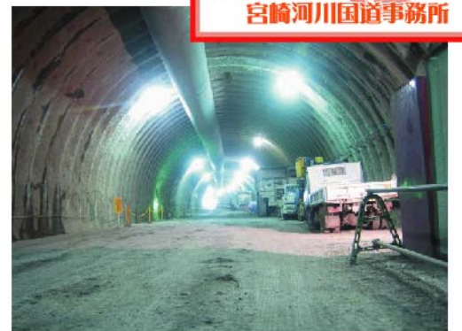
堀切トンネル工事中
