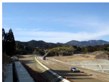
開通区間の状況（H20. 1時点）
