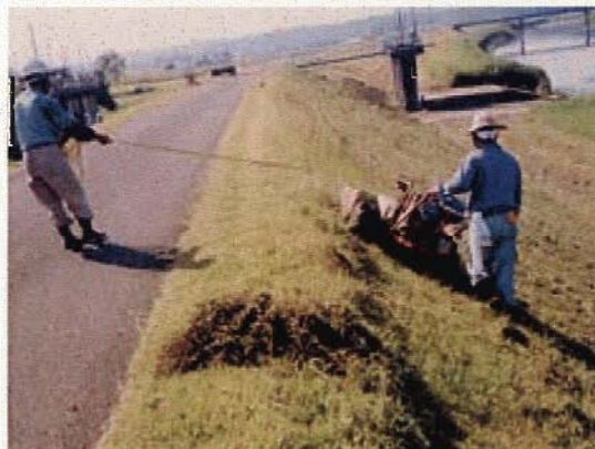
堤防の除草作業の様子
