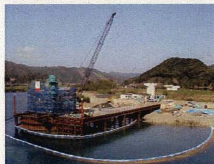
▲北川第二橋下部工工事
