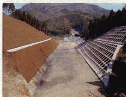
▲熊野江地区改良工事
