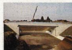
中原3号橋完成状況
