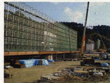
広渡川2号橋上部工工事
