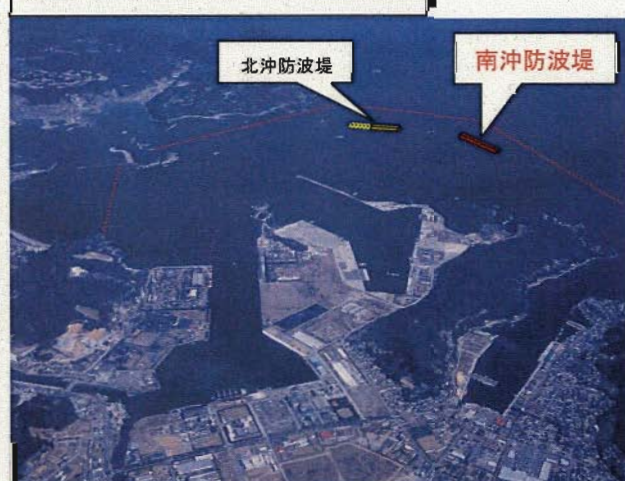
細島港(外港地区)南沖防波堤
