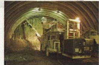
芳ノ元トンネル掘削工事
