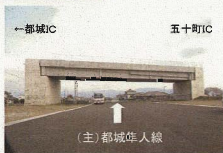
平塚橋完成状況
