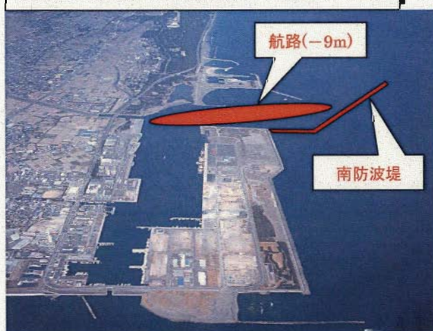
宮崎港(東地区)南防波堤及び航路(−9m)
