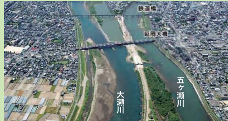
隔流堤の施工状況
