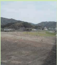
野田地区河道掘削施工後
