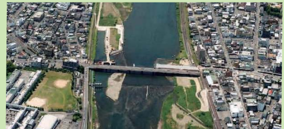
安賀多橋架替の状況
