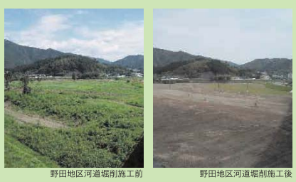
野田地区河道掘削施工前 野田地区河道掘削施工後
