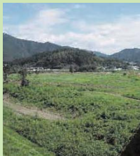
野田地区河道掘削施工前
