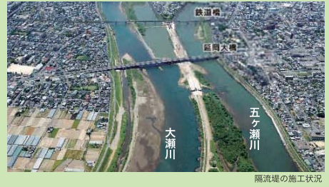
隔流堤の施工状況
