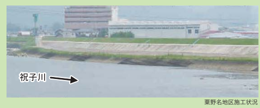
粟野名地区施工状況
