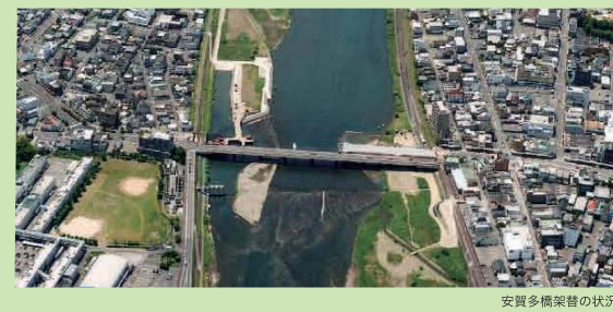
安賀多橋架替の状況
