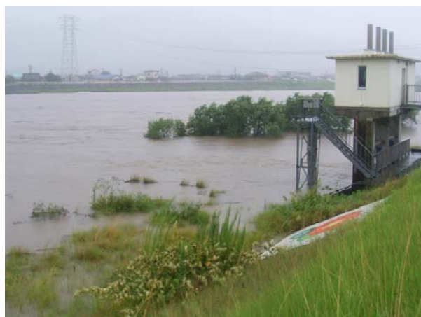
大瀬川左岸 桜小路樋門下流 (15:42)
