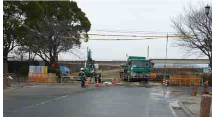
工事用道路で活用中（H24. 2月撮影）
