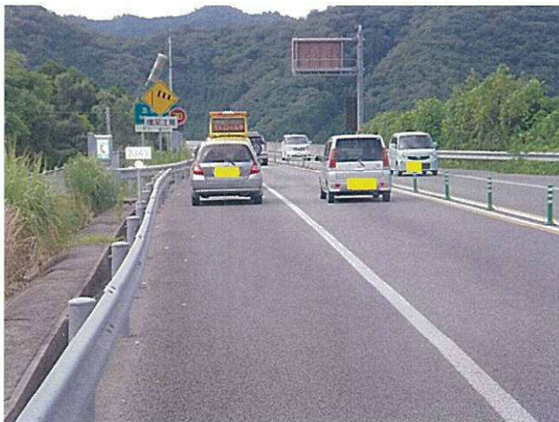
▲非常駐車帯等の駐停車状況
