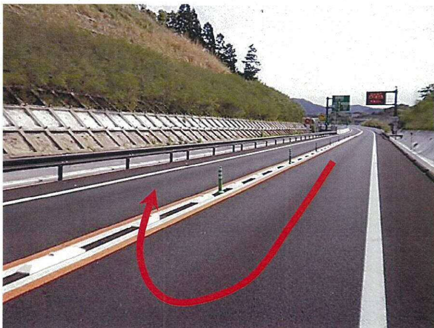
▲中央帯形式(ラバーポールと中央分離帯ブロック)箇所における自動車等のUターン状況
