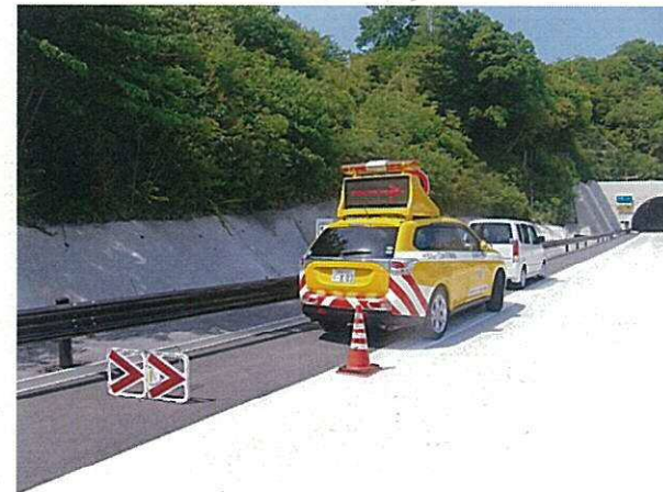
▲路肩でのパトロール車による後尾警戒状況
