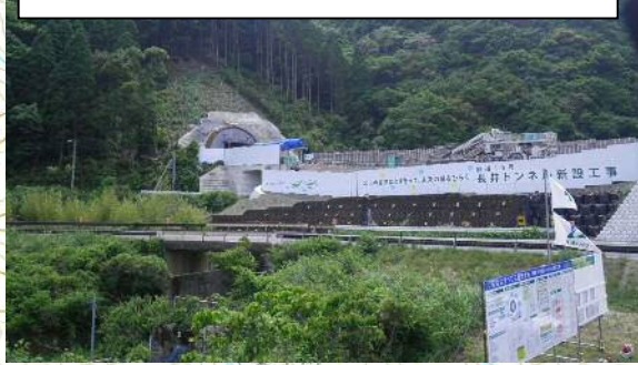
見学現場②延岡市北川町長井 (長井トンネル・北から望む)
