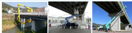
橋梁点検車による点検
