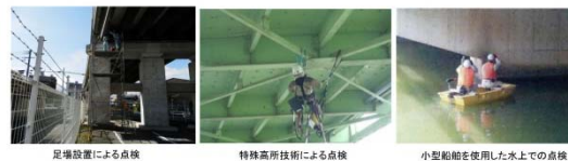
足場設置による点検
