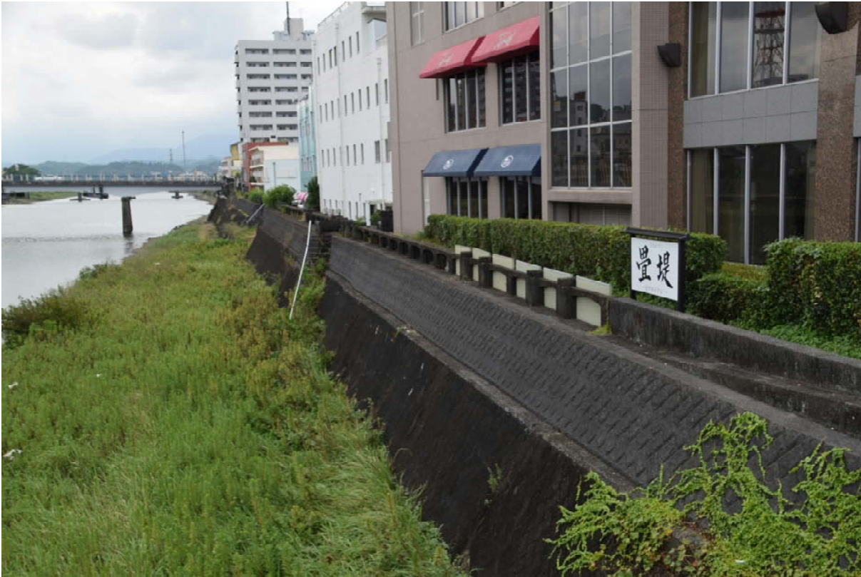
現在の壘堤の状況（延岡市紺屋町1丁目：ホテルメリージュ前から上流を望む）
