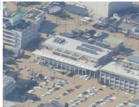
常総市役所の浸水の状況
